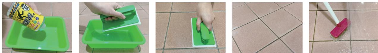
將防滑劑輕輕壓入塑膠盆 (施作前先清潔地板，保持乾燥)。用絨布刷吸滿防滑劑後，斜拿絨布刷，直至平拿不會滴。由左至右均勻塗抹防滑劑於磁磚。讓防滑劑停留表面，靜置10-15分鐘。以清水刷洗乾淨即完成。
